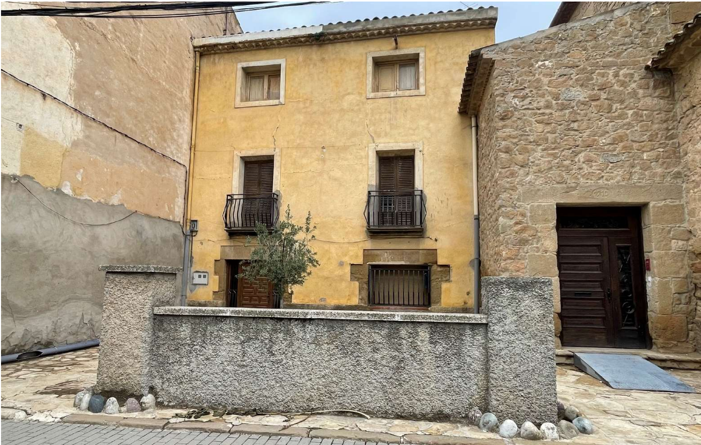
Imatge 08: Edifici objecte de la intervenció. Accés des del carrer Major
