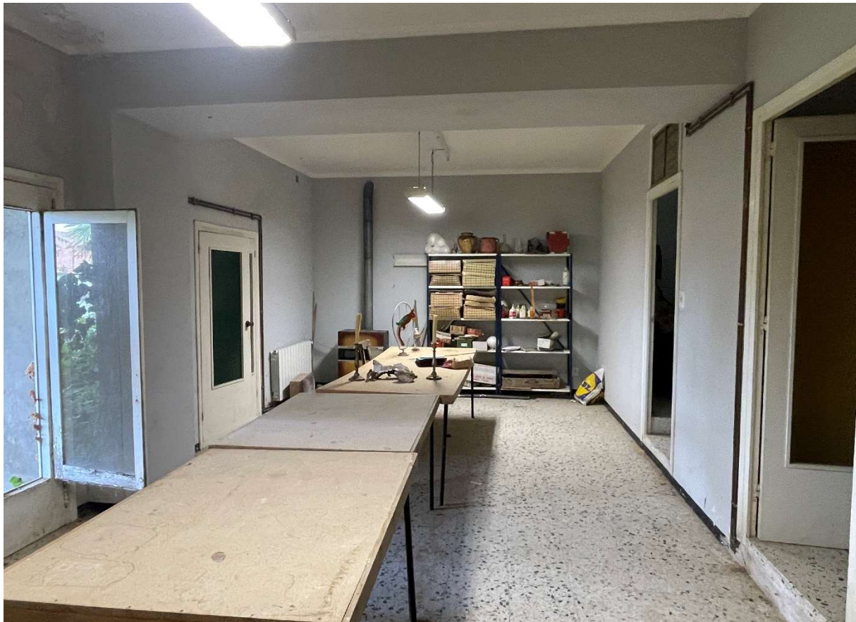
Imatge 07: Estat actual sala posterior de planta baixa
